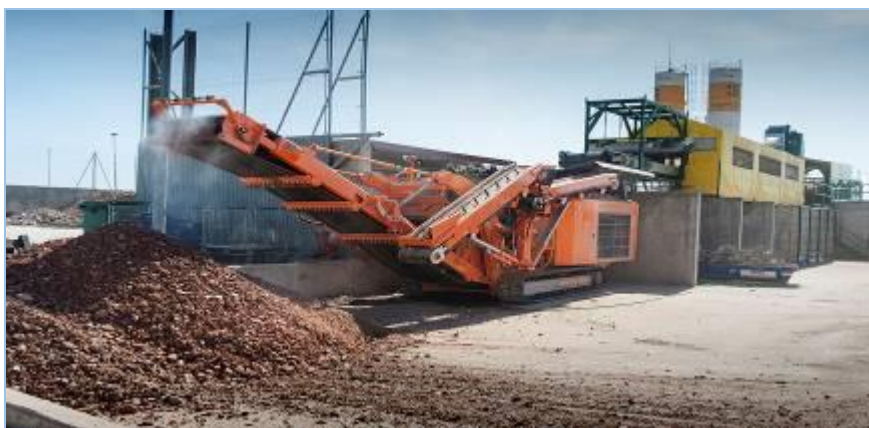
Ilustración 8. Planta fija de reciclaje de RCD
