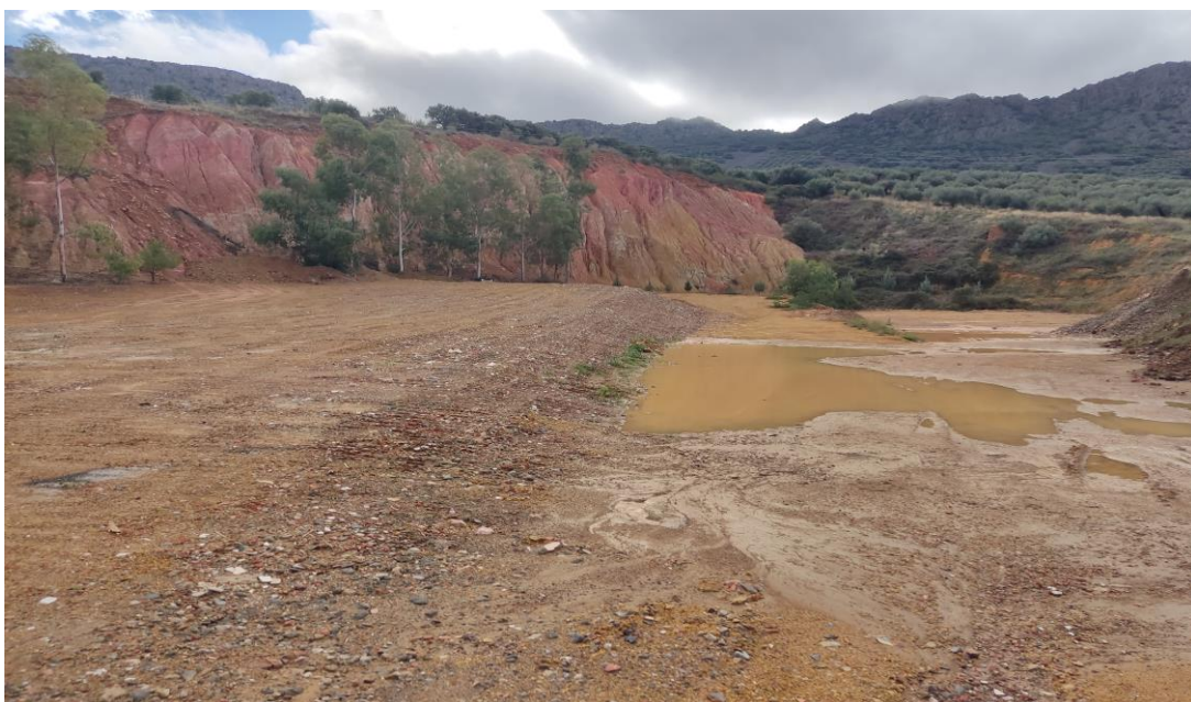
Ilustración 3. Trabajos de restauración ambiental utilizando RCD inertes en una explotación minera de Cabeza del Buey (Badajoz).
