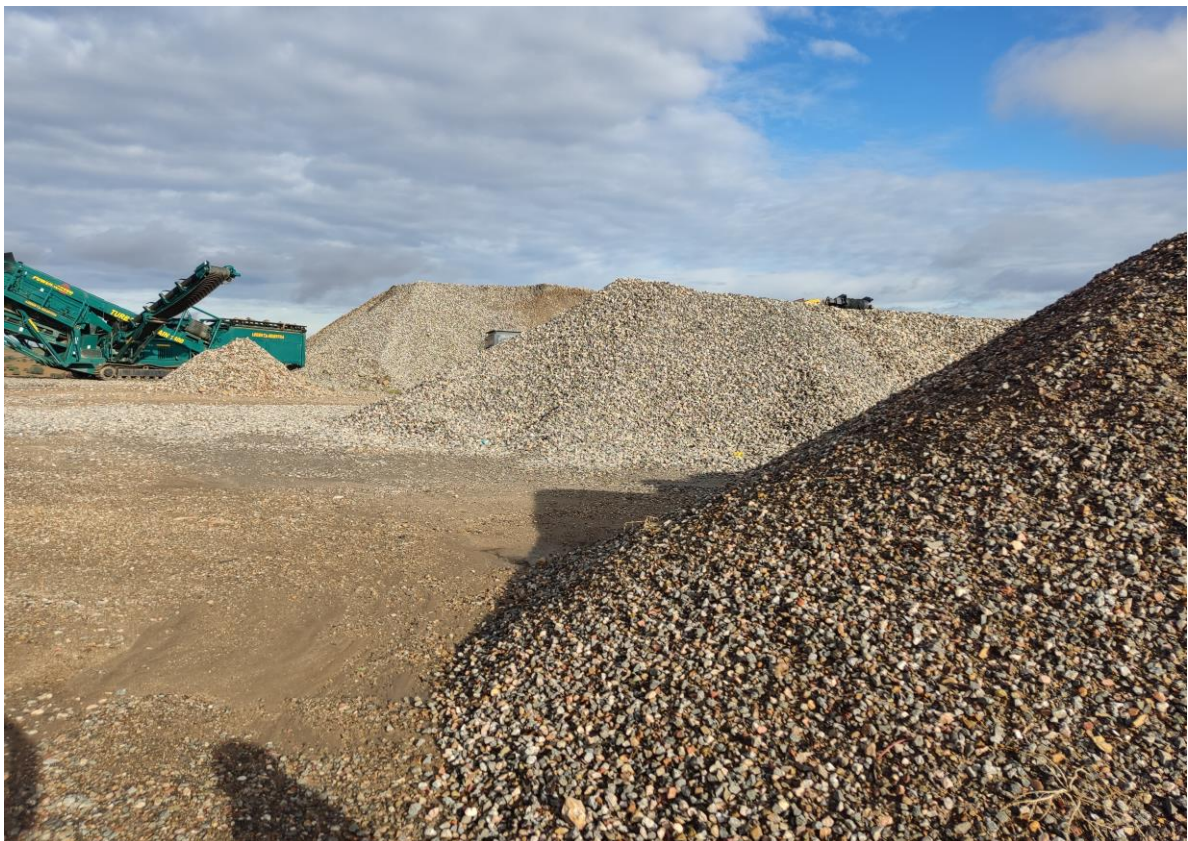
Ilustración 1. Tratamiento de RCD en una planta de reciclaje autorizada.
