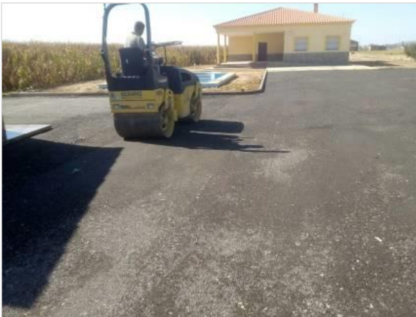
Ilustración 10. Aplicación de árido reciclado en una explanación.
